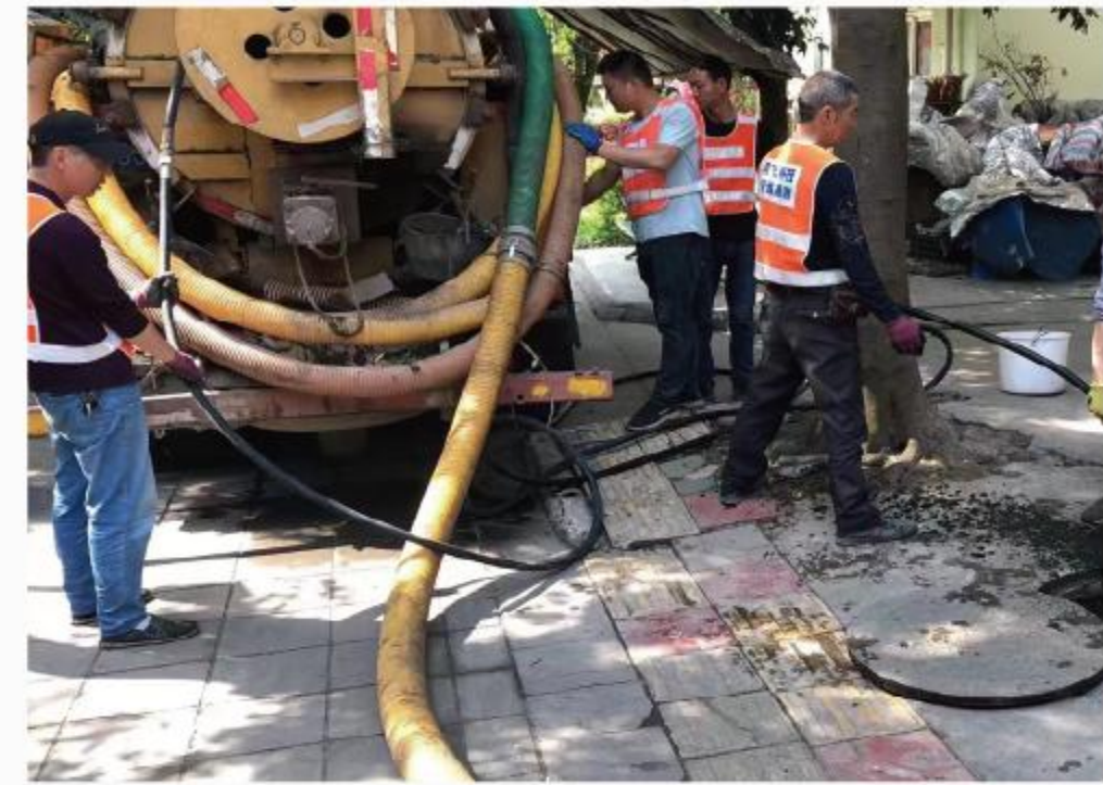
成都区级 管网养护项目
