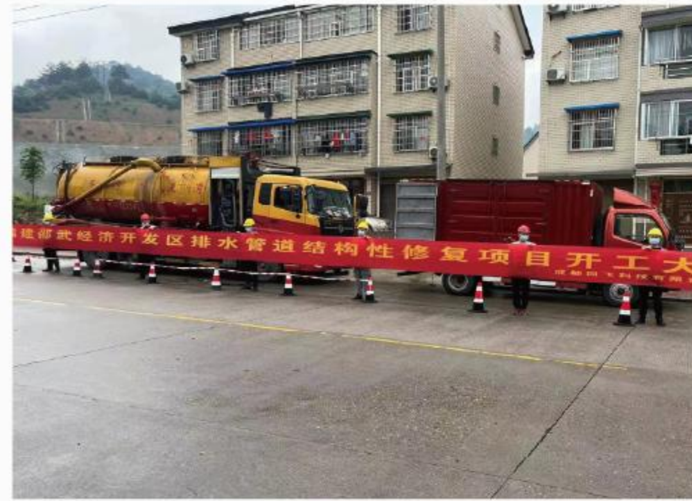
福建市级 排水管网修复项目
