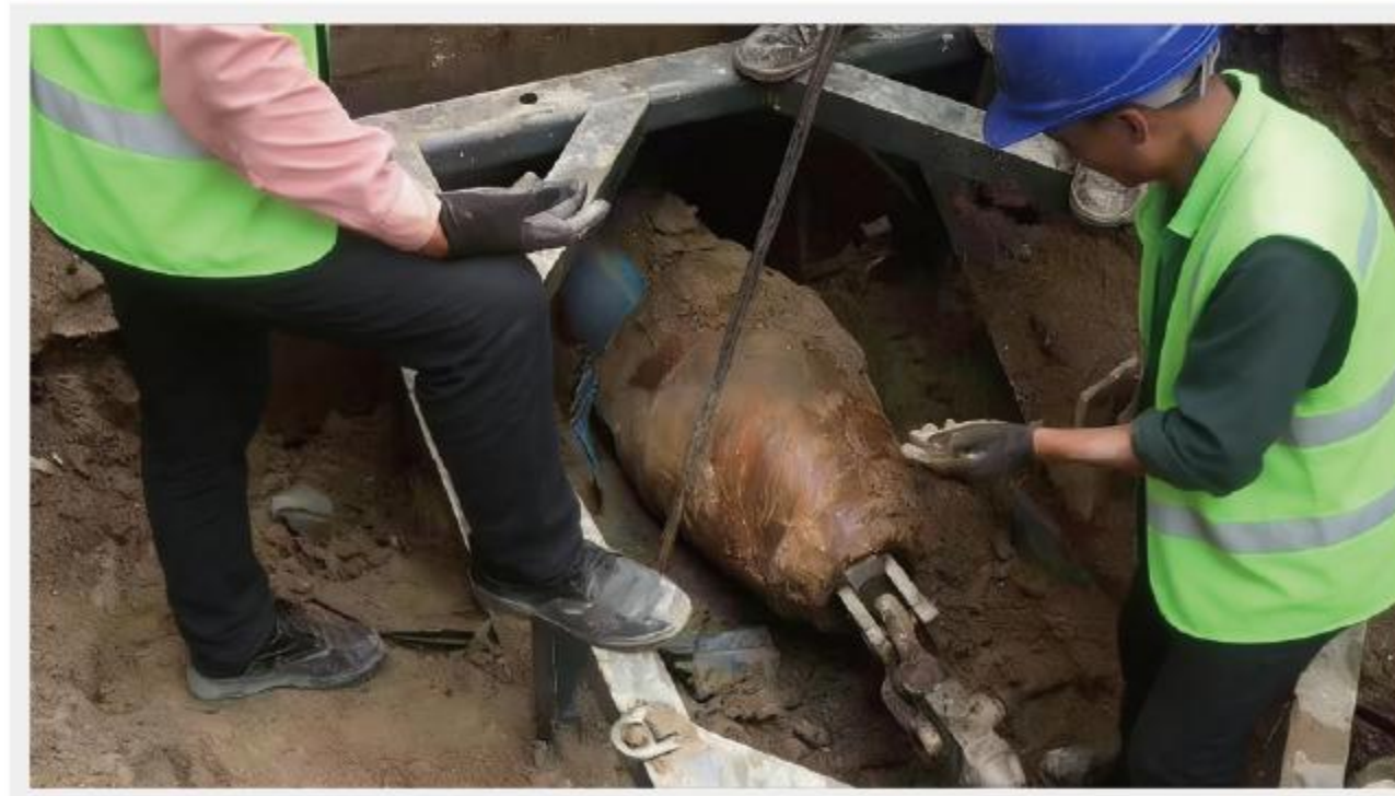
非开挖修复现场
