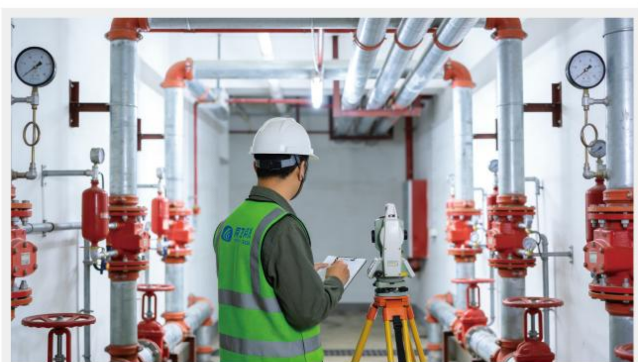
楼宇内部 管网测绘现场图
