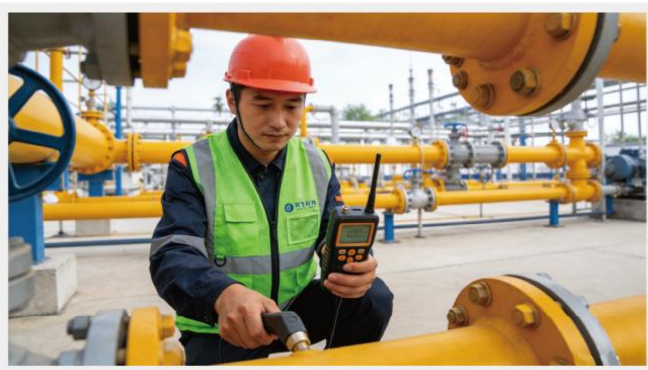
燃气检漏设备操作场景
