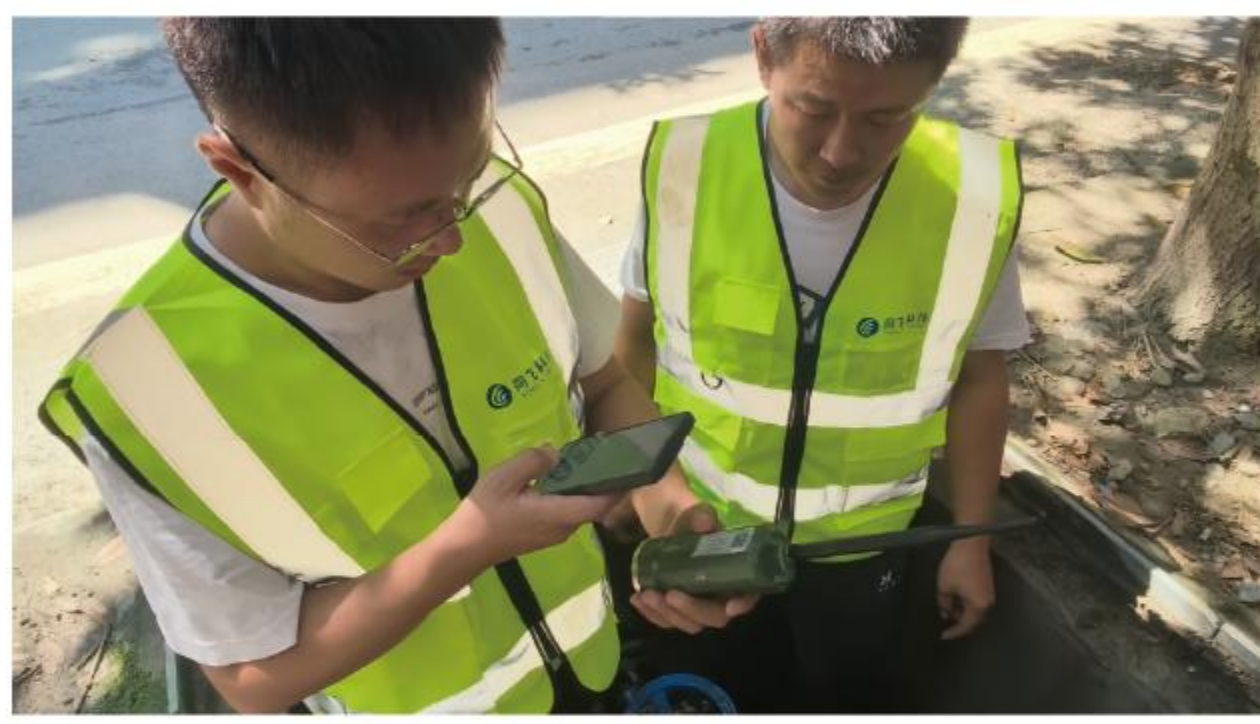
探漏设备操作现场
