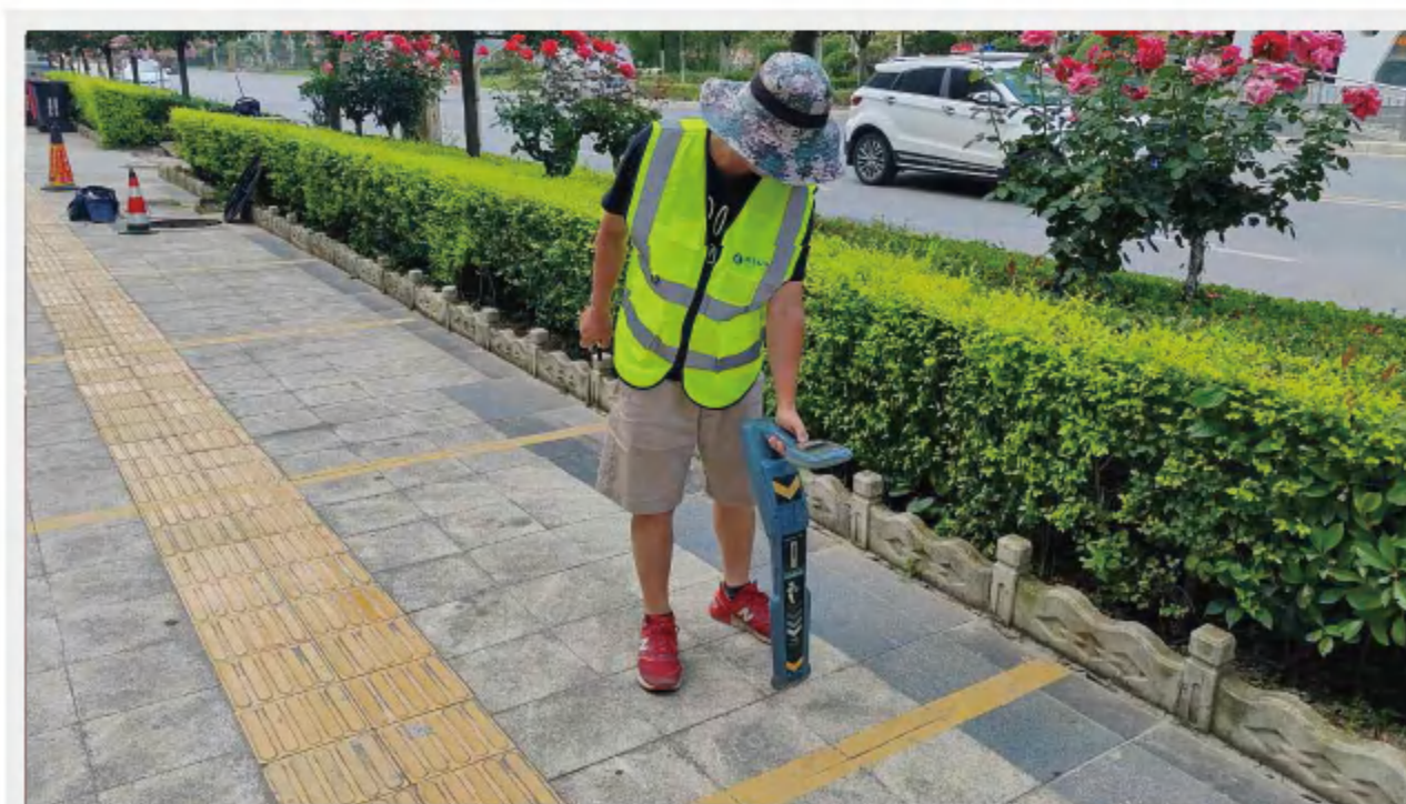
供水管道探测现场
