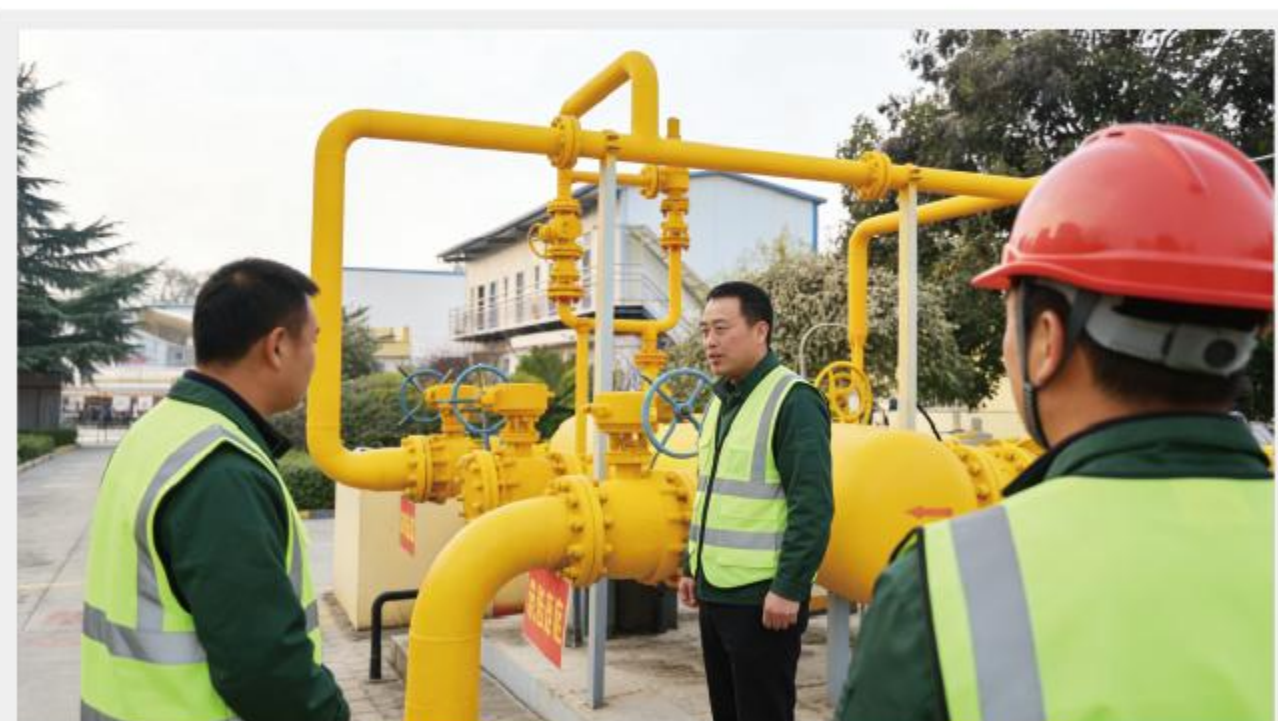
设备检测现场
