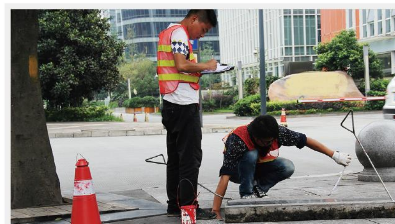
现场测绘操作场景
