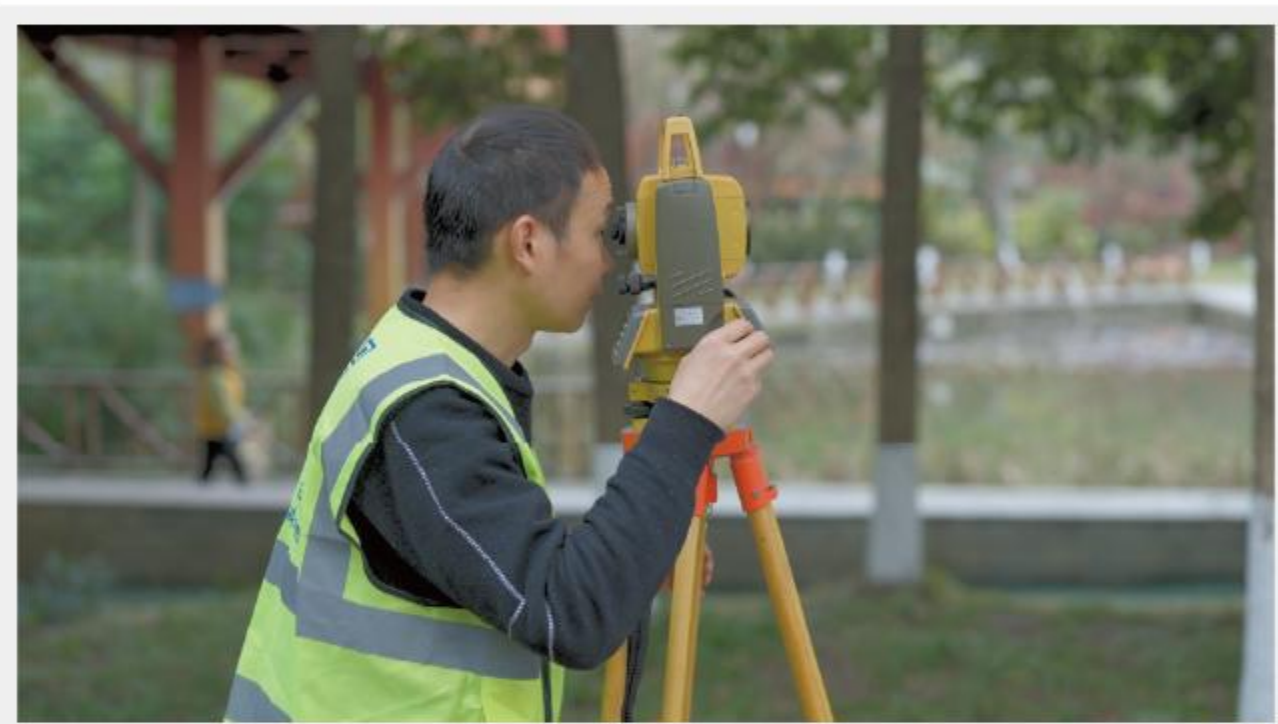
燃气管网测绘
