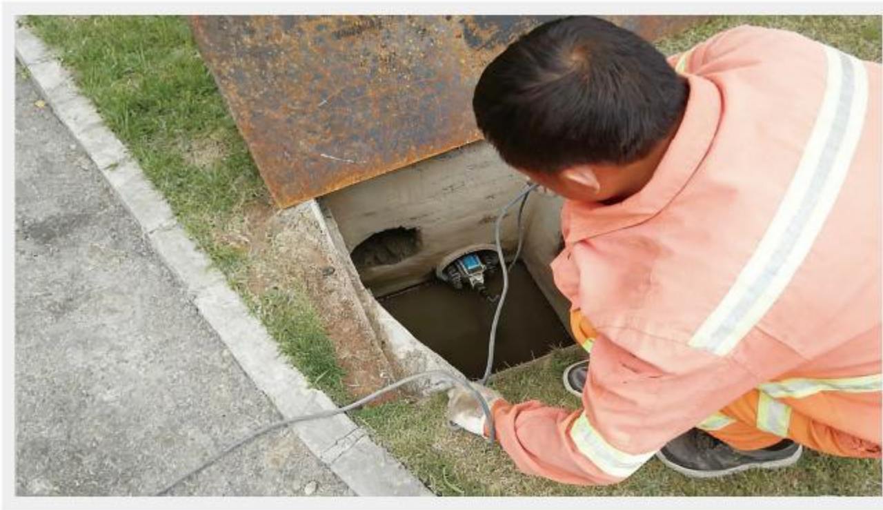
CCTV内窥检测设备 现场操作图
