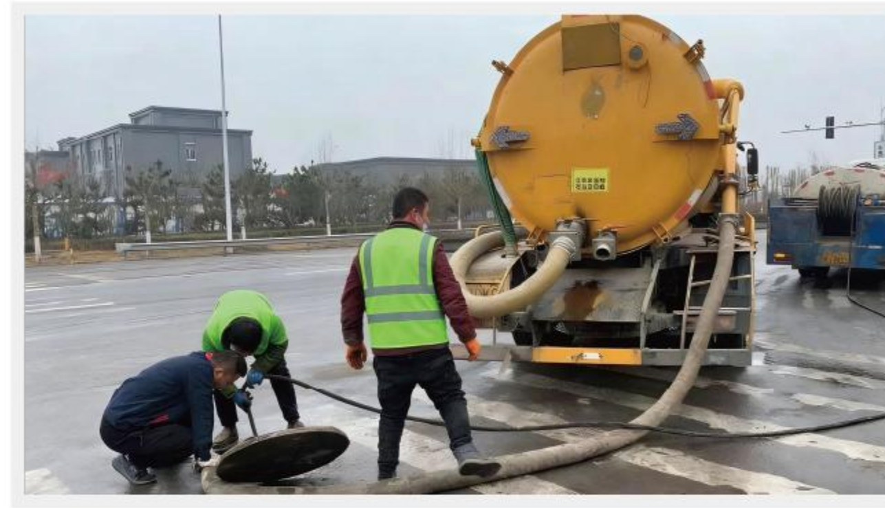
管道清淤作业场景
